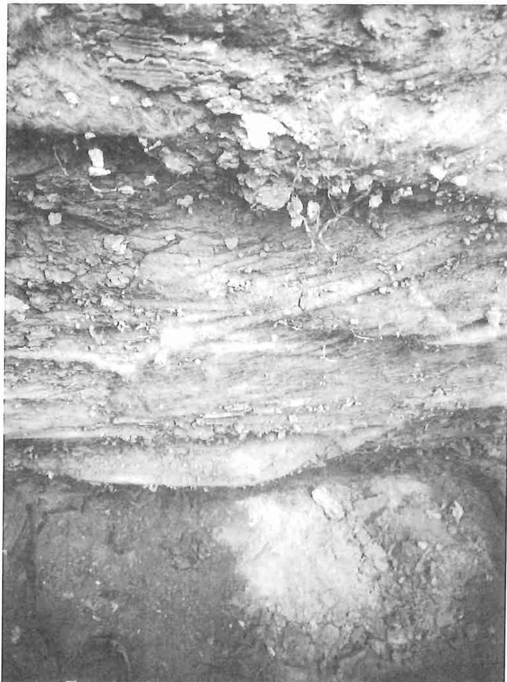
Příloha č. 3 – Detail zdegradovaného izolačního pasu a na vnější stěnu suterénu
